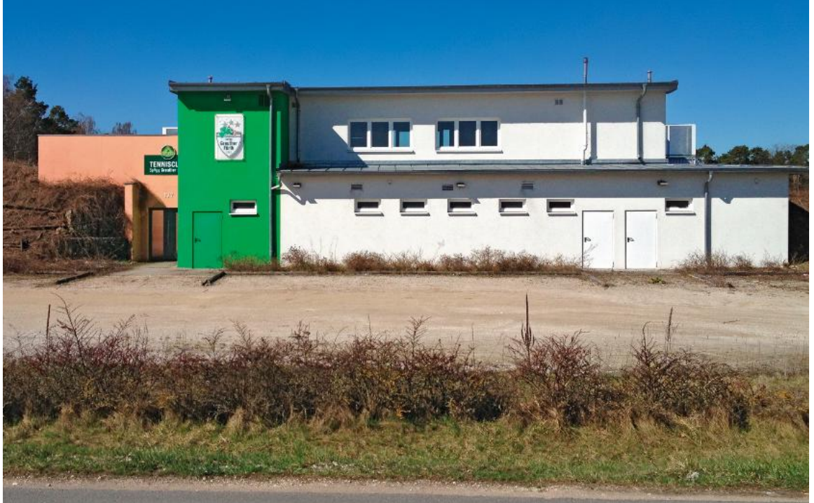
Das bereits bestehende Gebäude der ehemaligen Tennisabteilung wird in das neue Trainingszentrum integriert. [F: Tobias C. Auer]
